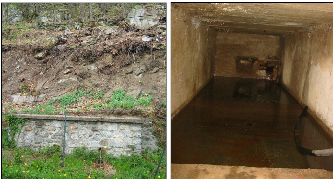
Figure 5 – Captage de la source des Bouscarasses (vue extérieure avec grillage du Périmètre de Protection Immédiate côté route et vue intérieure avec arrivée du canal au fond)
